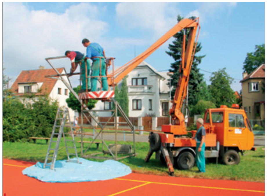
Při dokončování prací na víceúčelovém sportovním hřišti přišla ke slovu i plošina na „multikáře“
